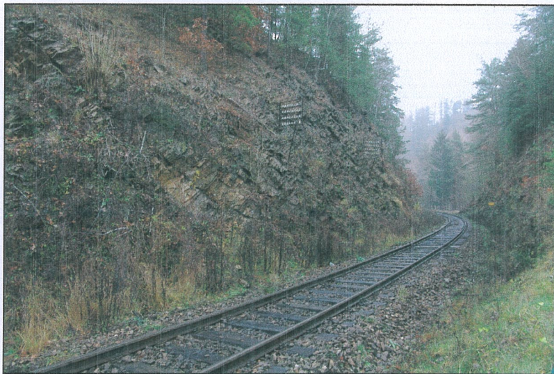
Obr. 5 Skalní zářez v km 12,000, pohled směr Brno. Ve stěně jsou patrné stopy po opadávání větších horninových fragmentů
