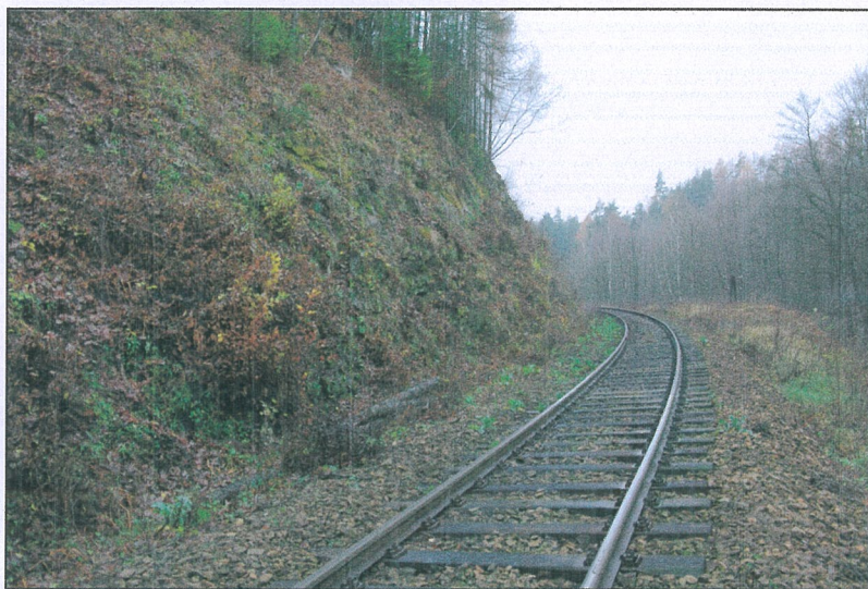
Obr. 1 Skalní stěna v km 11,640 tvořená ortorulou, pohled směr Jihlava
